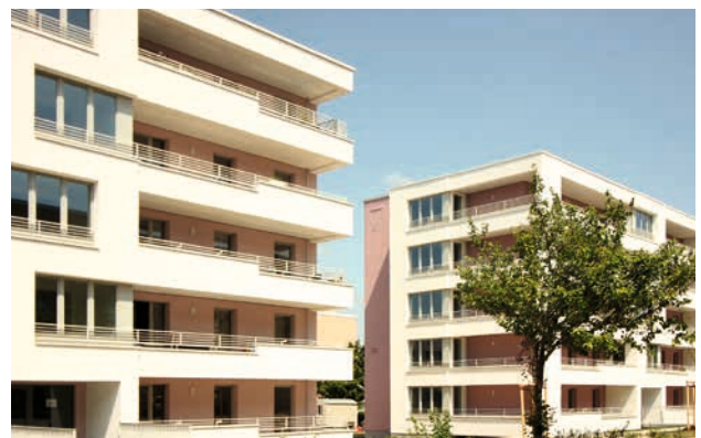
Moderne Architektur, Irkutsker Straße 187– 195
