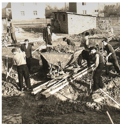
Baugrubenaushub Reichenbrander Straße
