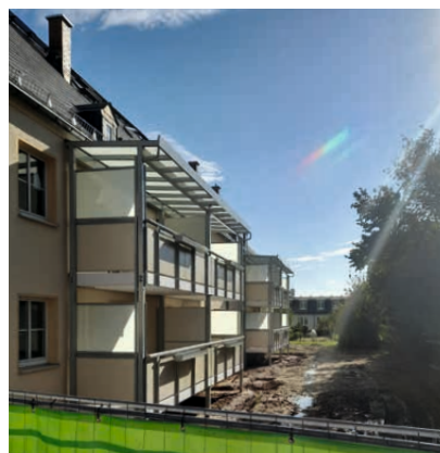
Balkonanbau am Birkenhof 9 – 11
