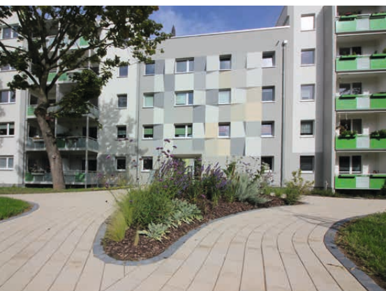
Neu gestaltete Außenanlagen an der Irkutsker Straße 117 – 123
